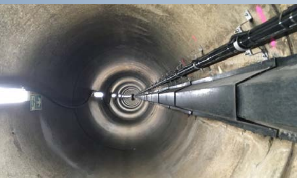
Schmutzwasser-Düker unter der Elbe während der Bauzeit (Die Neonröhren wurden nur für die Bauphase montiert).
