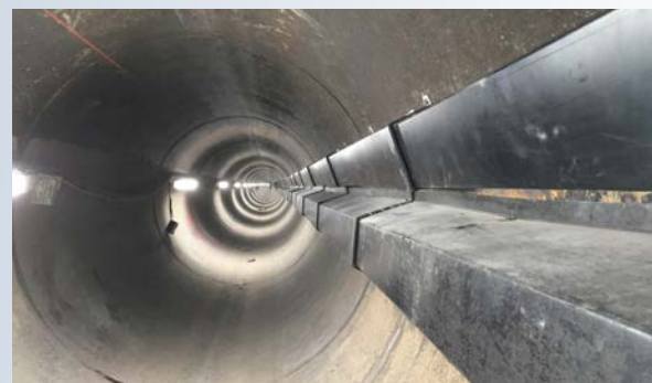
Schmutzwasser-Düker unter der Elbe während der Bauzeit (Die Neonröhren wurden nur für die Bauphase montiert).
