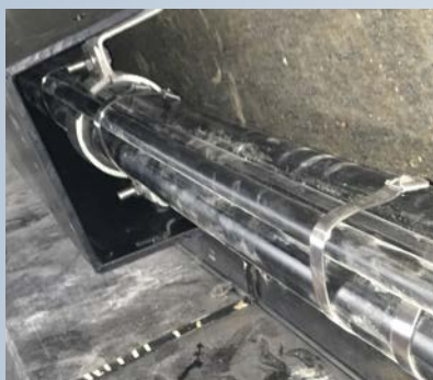
Schmutzwasser-Düker unter der Elbe während der Bauzeit (Die Neonröhren wurden nur für die Bauphase montiert).
